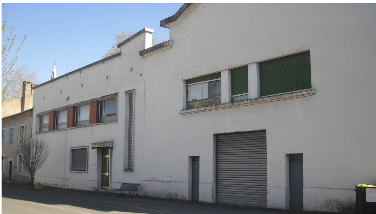
Façade nord du bâtiment, Roquecourbe, avenue de Castres
